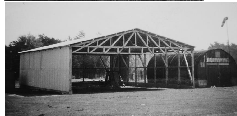
Die erste Flugzeughalle! Sie steht heute noch in Ringheim und wird gewerblich genutzt!
