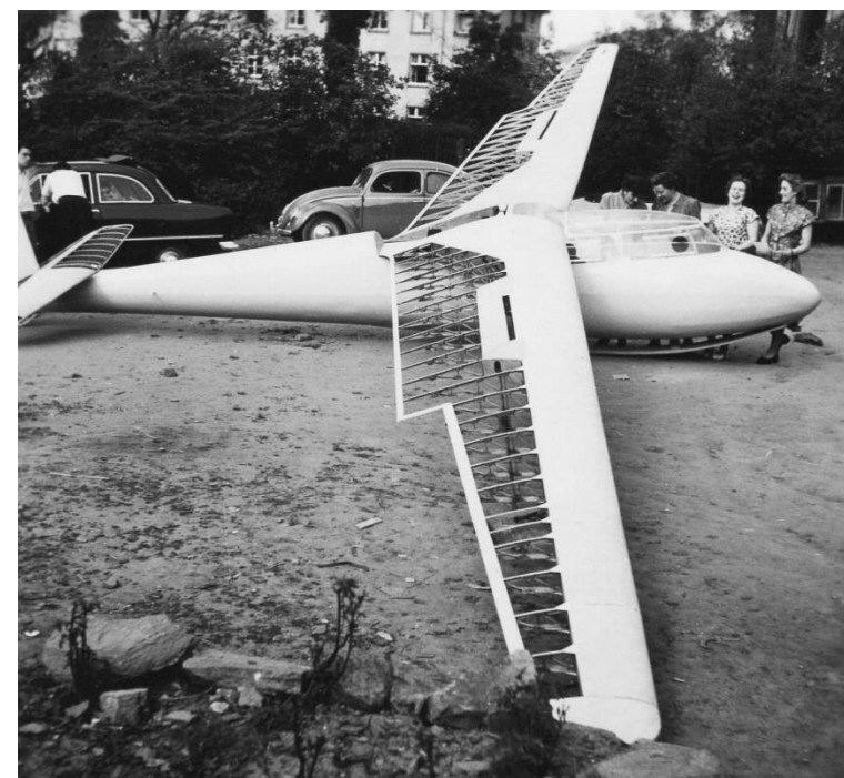
Bau der Ka 2 im Neuhof
